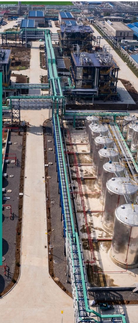
位于金山厂区的年产 5 万吨甲基丙烯酸特种酯项目被淄博市政府列为“2020 年重点项目”，现已建成的三套装置 7 条生产线，均采用先进设备和生产工艺以及 DCS 中央控制系统，并配套建成了储存罐区近万立方、标准桶自动灌装流水线 4 条和 16 鹤位高效槽车装卸平台、先进高效的催化氧化废气处理装置，以及一流的研发测试中心。
